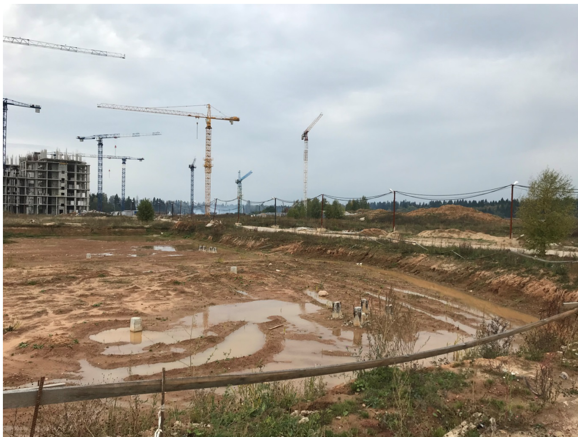
Рис. 2.2. Общий вид объекта.
